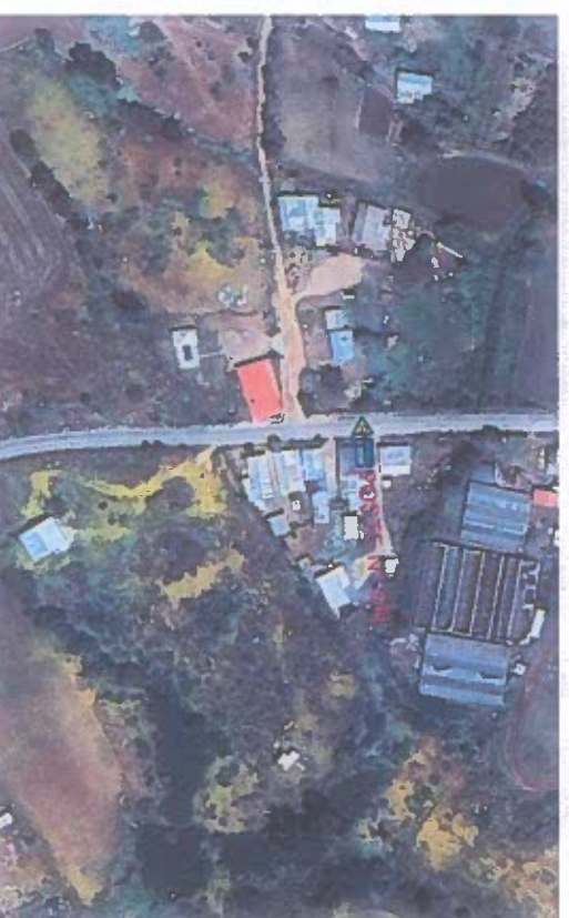
LUMINARIAS SECTOR MANQUEHUA 1 Luminarias
