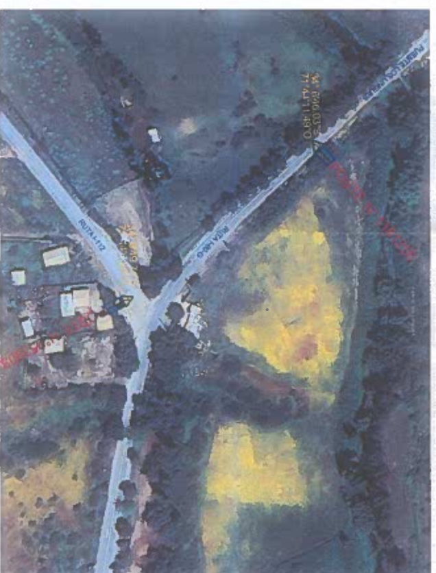
LUMINARIAS LOS LINGÜES 2 Luminarias
