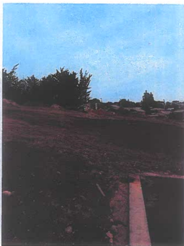
Situación Actual Construcción Canchas Pádel, Comuna de Litueche.
