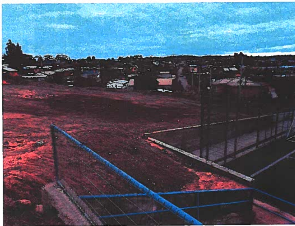
Situación Actual Construcción Canchas Pádel, Comuna de Litueche.
