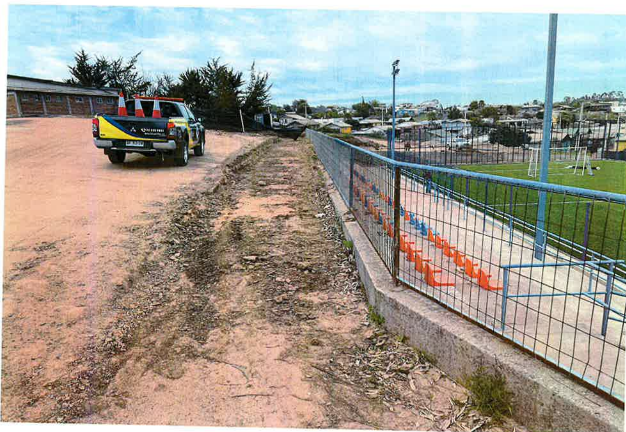
Imagen Terreno de Proyecto: "Construcción y Reposición Baranda Estadio Municipal, Comuna de Litueche".
