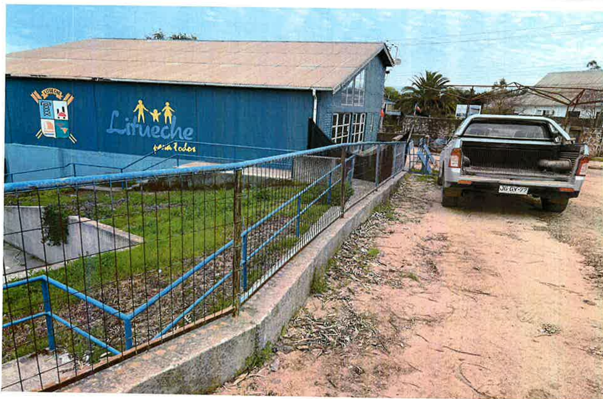
Imagen Terreno de Proyecto: "Construcción y Reposición Baranda Estadio Municipal, Comuna de Litueche".
