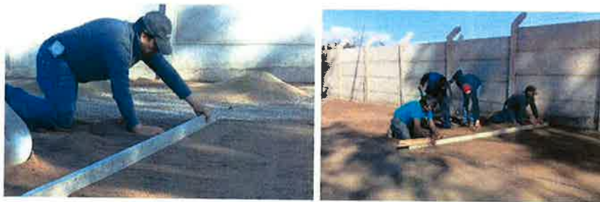
Confección de cama de arena con regla. Cuadrilla de trabajo con personal esparciendo la arena y otros compactando y alisando.
