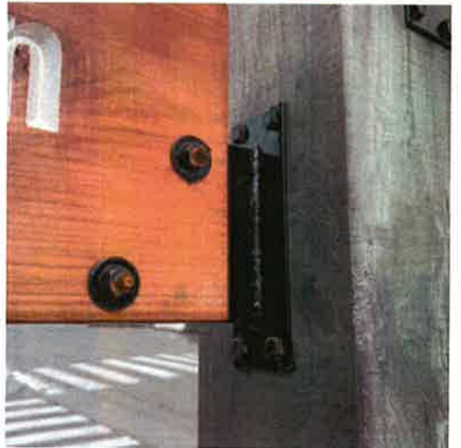
DETALLE UNIÓN INFERIOR SEÑALÉTICA A PILAR
