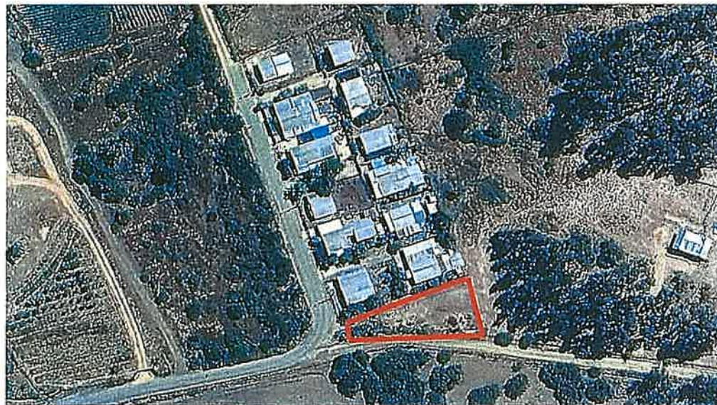
MEJORAMIENTO DE ESPACIOS PÚBLICOS VILLA FORJADORES Y SAN VICENTE, COMUNA DE LITUECHE. COORDENADAS: 34°00'48.9"S 71°42'48.0"W
