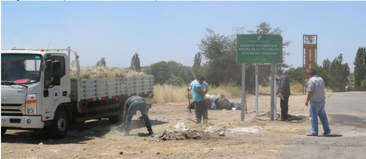
Fotografía N°9: Limpieza e instalación de letreros preventivos en microbasurales
