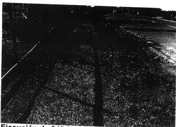
Ejecución de 242,8 metros con excavado y estabilizado compactado.
